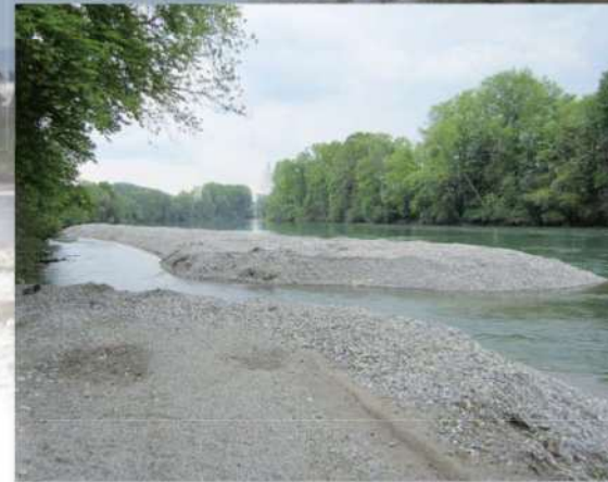
Abbildung 1: Im Januar 2010 in Aarwangen geschüttete Kiesbank (Foto Mai 2010)
