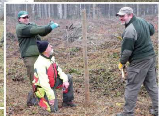
Auch dies ist Hegen: Reparatur des Schutzzaunes beim Joggihus (Bleienbach)
