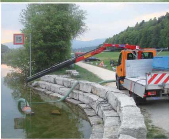
Leistungsstarke Pumpe, die Aarewasser in den Anstreckteich pumpt.
